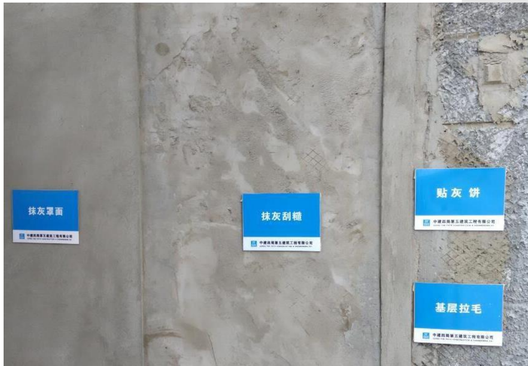
图7-6 贴灰饼、冲筋、分层抹灰
